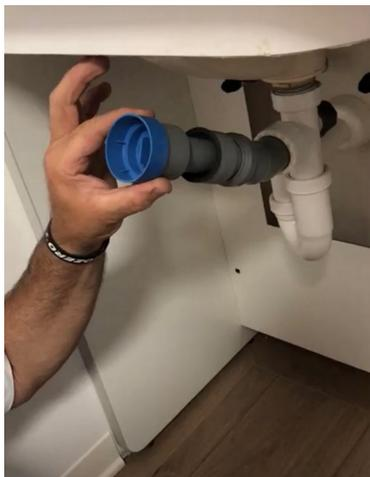
Avvitare i nostri attacchi 3/8 maschio ai rubinetti e inserire i tubetti acqua calda e acqua fredda. Portare l'estremità opposta dei due tubetti nel lavandino e procedere a farli scaricare di acqua e aria prima d'inserirli nello strumento iClean14
